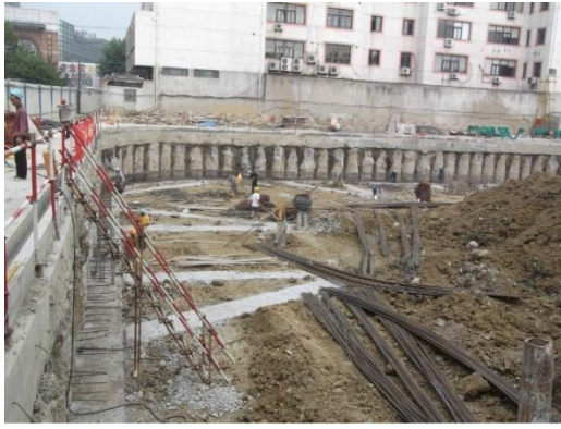
第一道支撑部分垫层及钢筋绑扎
