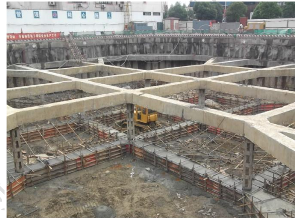
第二道支撑砼浇筑
