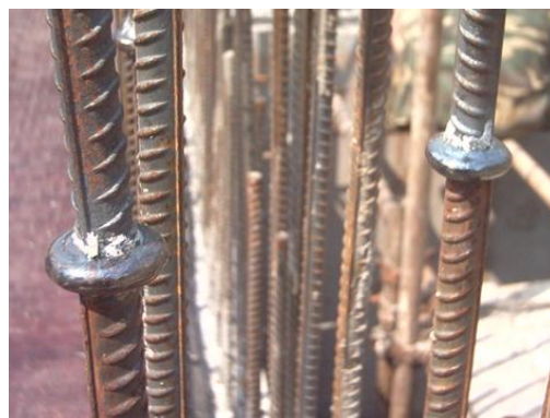
电渣压力焊
