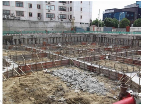
第一道支撑砼浇筑
