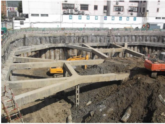
第二层土方开挖
