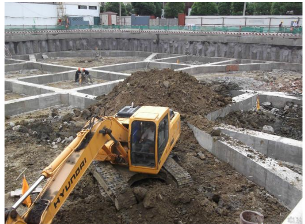
第二层土方开挖
