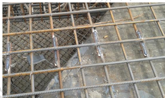
钢筋电弧焊
