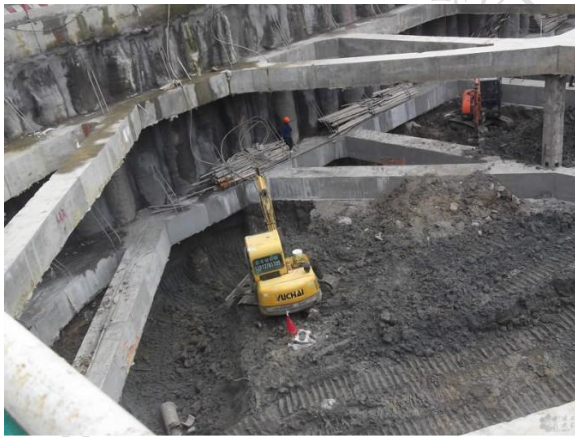
第三层土方开挖
