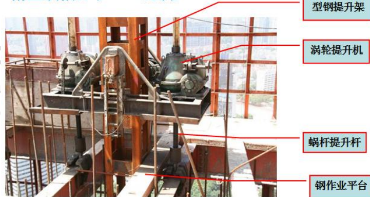
新型模板体系——爬模施工
