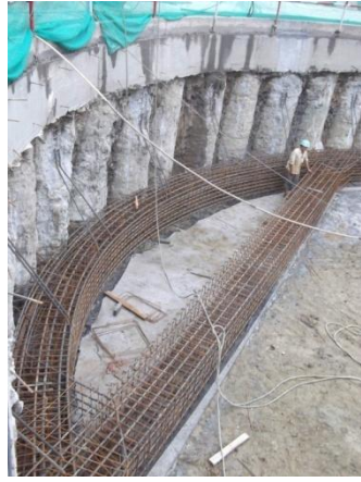
第一道支撑钢筋绑扎
